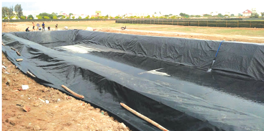
Hình 8. Hình minh họa chống thấm ao/hồ trích trữ nước ngọt
