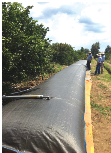
Hình 10. Lắp đặt các phụ kiện và bơm nước vào túi chứa nước
