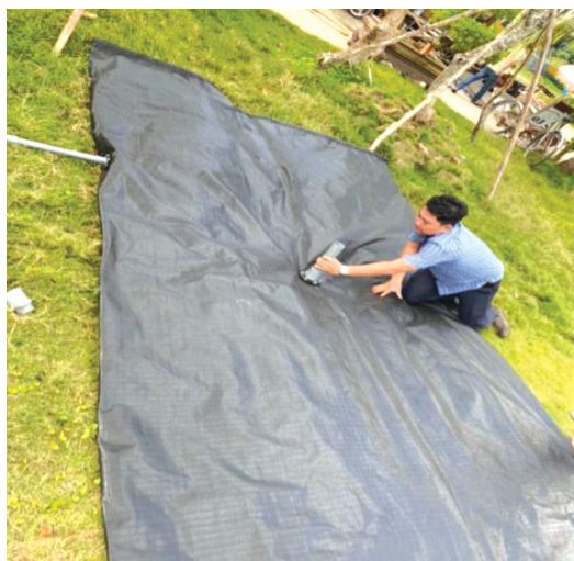
Hình 10. Lắp đặt các phụ kiện và bơm nước vào túi chứa nước
