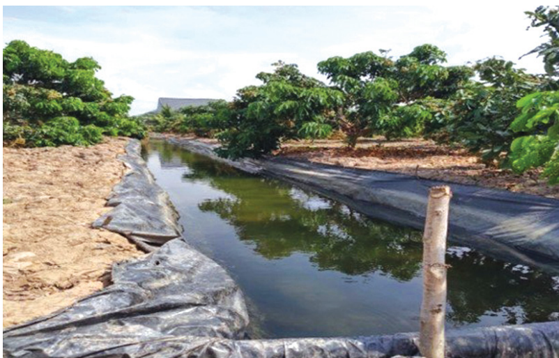
Hình 7. Trại chống thấm mương vườn cây bằng bạt HDPE
