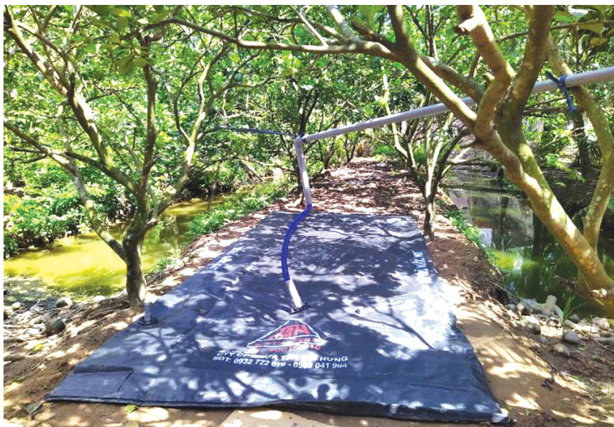
Hình 9. Chuẩn bị lắp đặt túi trữ nước
